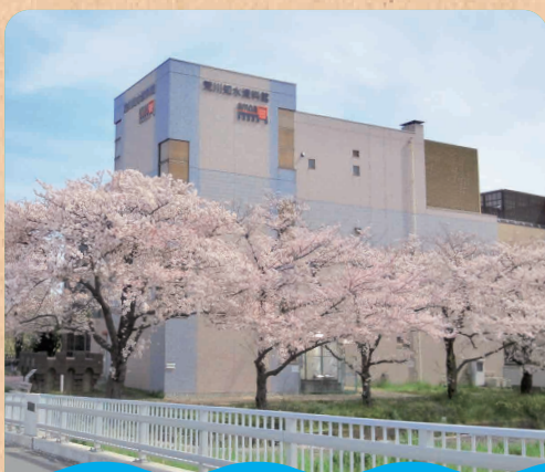
荒川知水資料館
